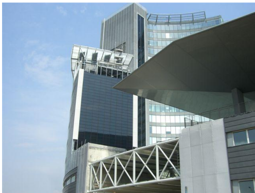
Bild 2: GeneCIS Module von Würth Solar in der Fassade des World Jewellery Centers in Mailand. Der erzeugte Strom wird direkt für die Gebäudeautomatisierung verwendet. (Quelle: Würth Solar)
