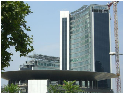
Bild 1: GeneCIS Solarmodule von Würth Solar in der Fassade des neuen World Jewellery Centers in Mailand. 1.071 Module zieren die Fassade des Hochhauses (Quelle: Würth Solar).
