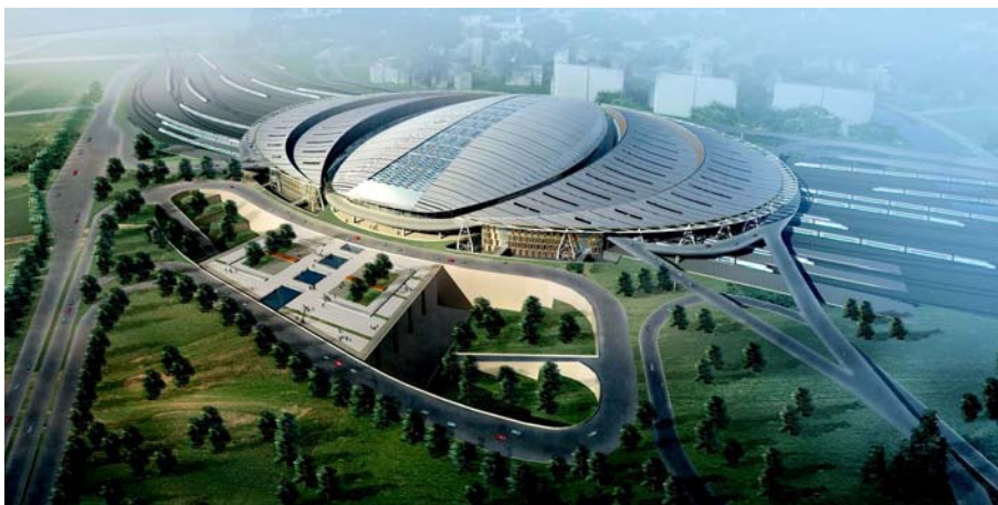
Der neue Pekinger Südbahnhof aus der Luft. Die Solarmodule von Würth Solar ziehen sich im Schachbrett abwechselnd mit Klarglasfeldern wie ein Band über die Mitte des Bahnhofs dachs. (Computersimulation. Quelle: Ruihua Construction Corporation)
